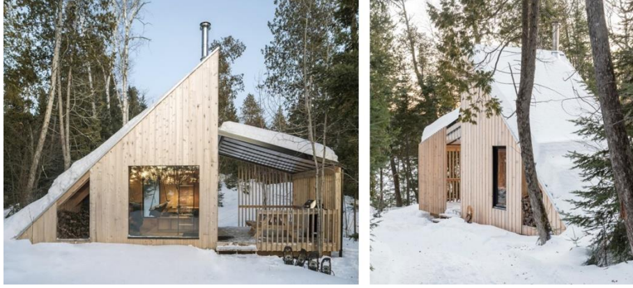
Şekil 13. La Pointe yapısının dış cephe görünüşü
